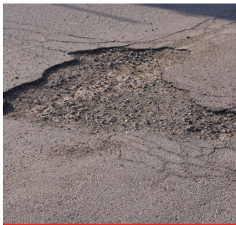
Limpiar la zona a reparar
