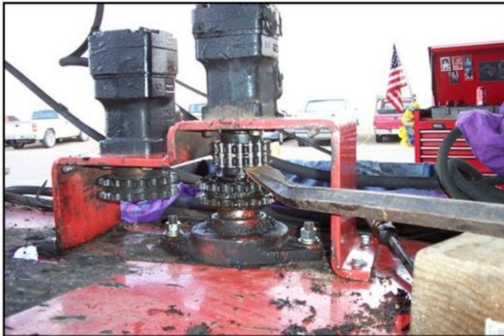
Figura 6-13 Colocación del Eje de la Bomba en el Motor de la Bomba Hidráulica
