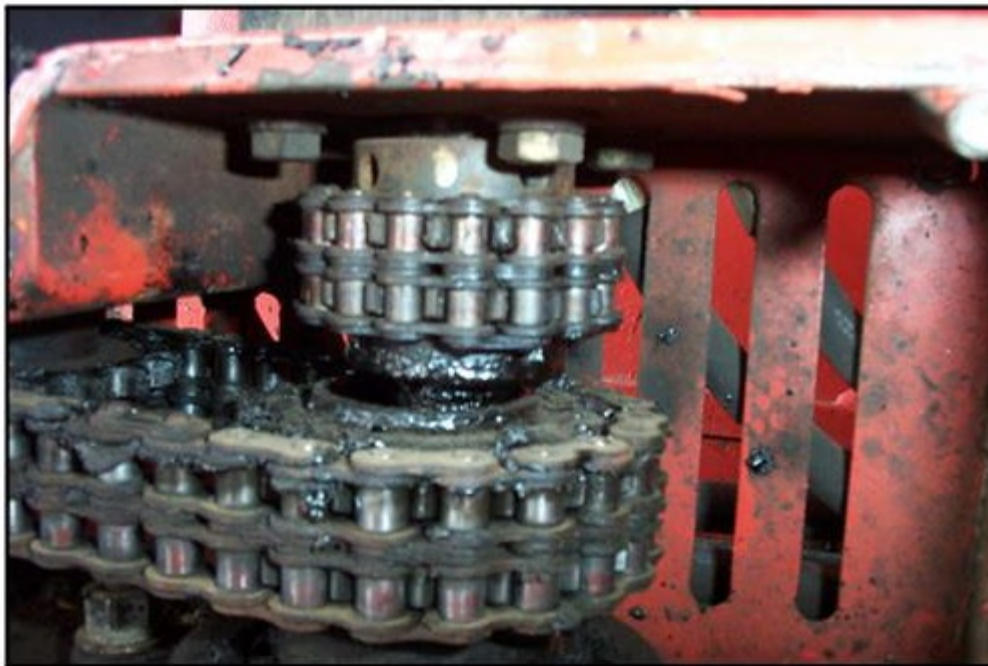
Figura 6-4 Alineamiento del eje del Agitador y la Bomba
