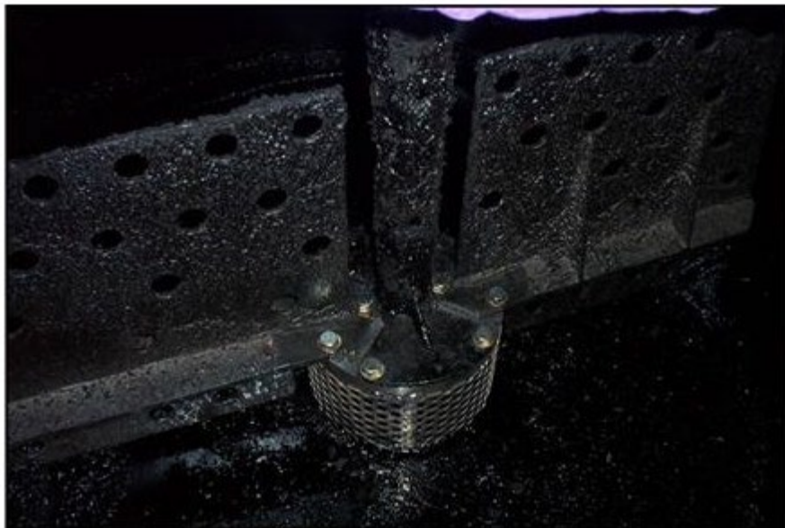
Figura 6-11 Montaje del Eje del Agitador y de las Paletas
